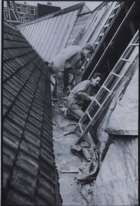
Het dak van 'de fabriek' in de Van Ostadestraat wordt gemaakt
